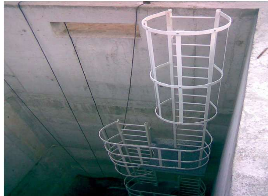
Escalera de seguridad con descansillo con crinolina de protección dorsal y barandilla
