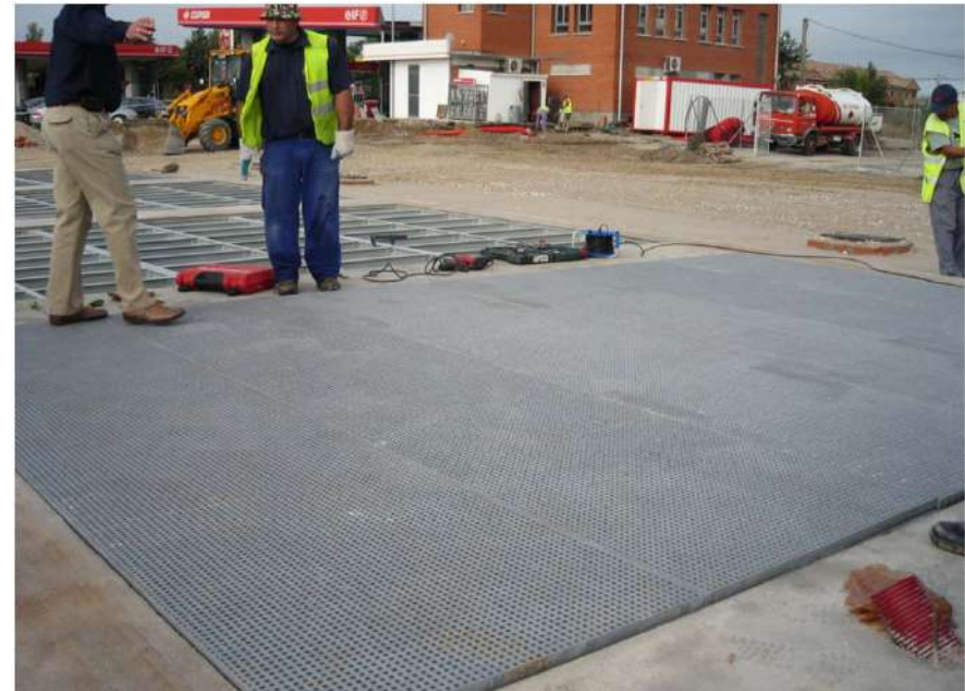
Estructura de soportación en cuadrícula y rejilla micromalla de 13 mm.
