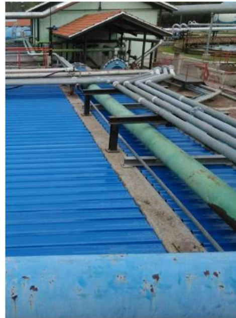
Cubierta ligera con plancha ondulada y soportación en PRFV
