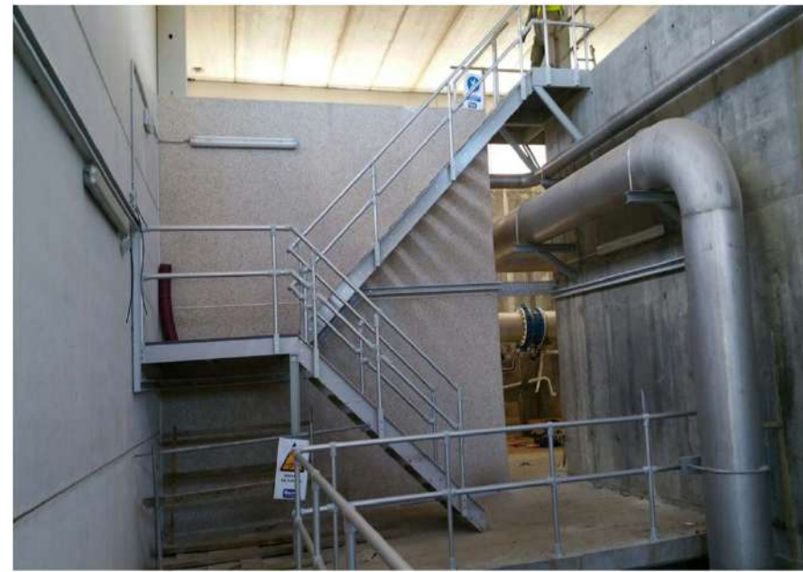
Escaleras inclinadas con descansillos acartabonados y barandilla de protección perimetral circular
