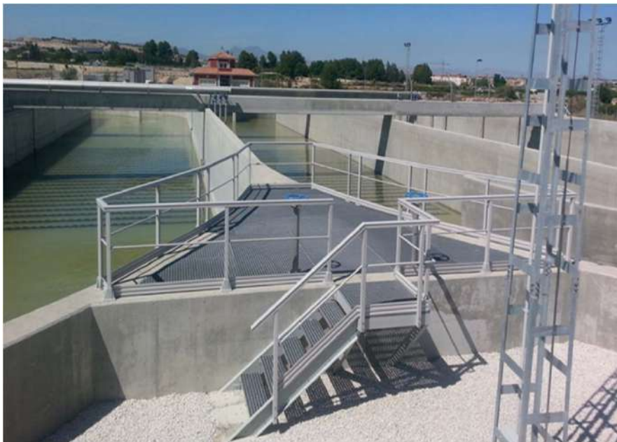
Sistema de pasarelas y plataformas acartabonadas con escaleras inclinadas y barandilla de protección perimetral ergonómica
