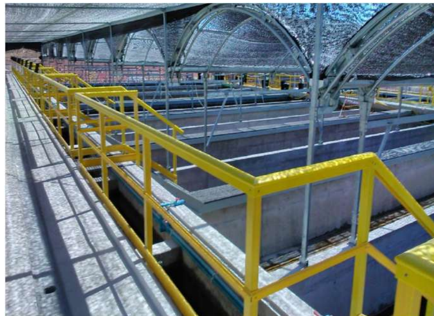
Cerramiento con barandilla de protección ergonómica y escaleras inclinadas protegidas a ambos lados
