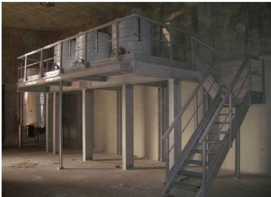
Plataforma en altura para soportación de depósitos incluyendo estructura de acceso y protección perimetral
