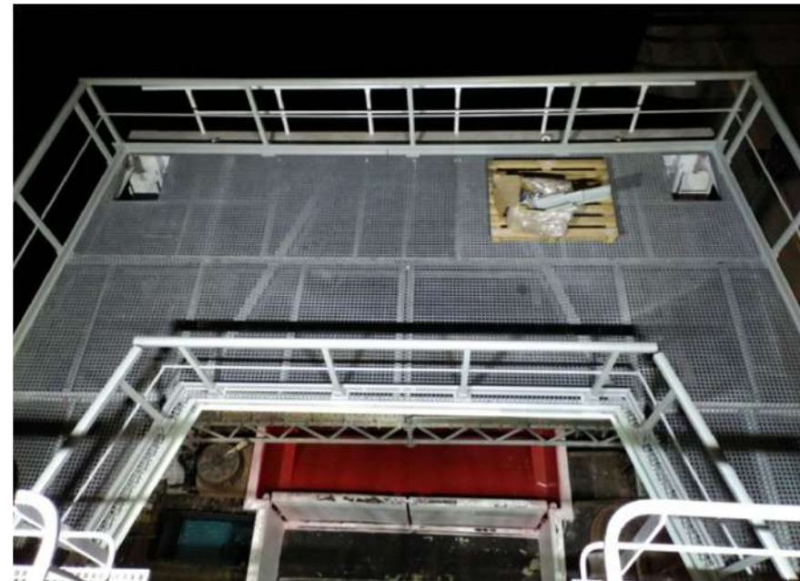
Plataforma en altura íntegramente de PRFV incluyendo barandilla de protección perimetral ergonómica, para aligerado de barco pesquero
