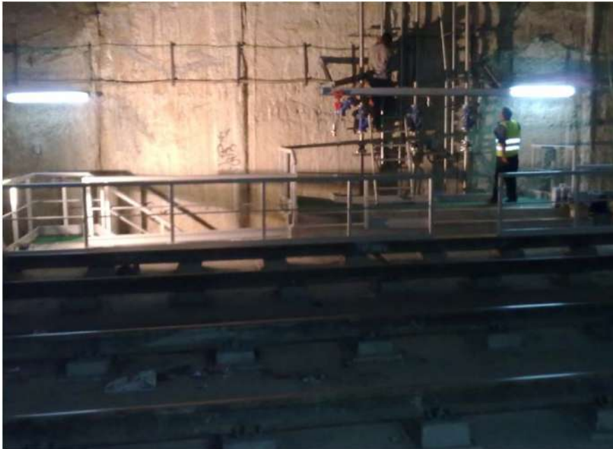
Plataformas con escaleras inclinadas y barandilla de protección perimetral ergonómica
