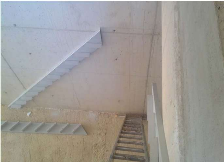
Sistema estructural de acceso y evacuación mediante escaleras inclinadas incluyendo descansillos en altura y protección a un lado
