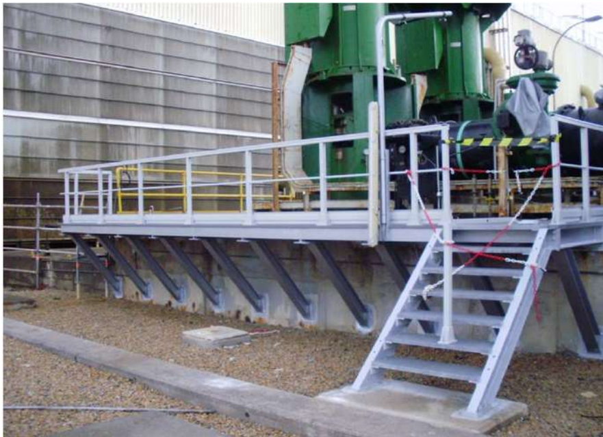
Alstom Cartagena (Murcia). Septiembre de 2010 Plataformas, escaleras y barandillas
