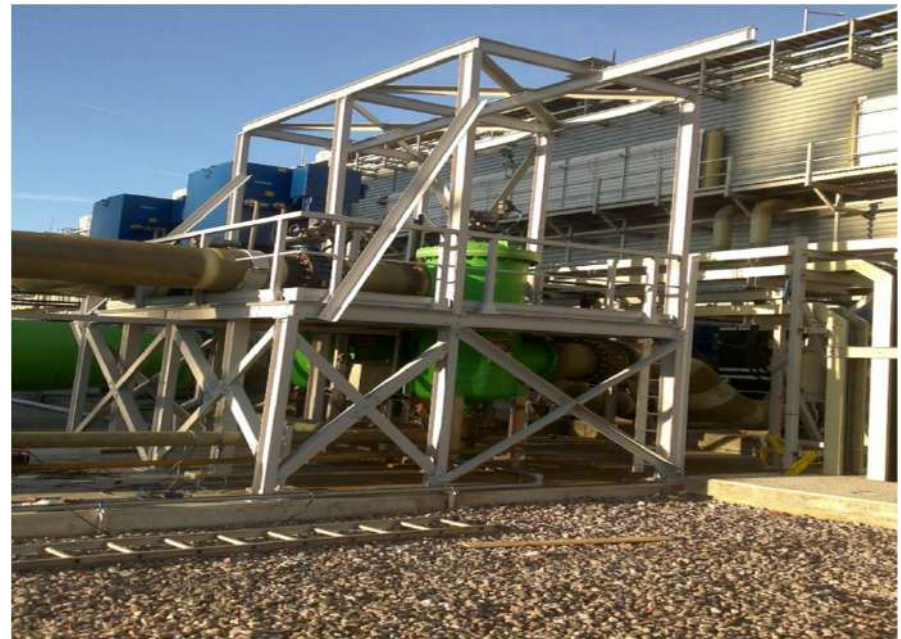
Enagas Port de Barcelona. Octubre 2010 Escaleras, barandilla y estructuras varias
