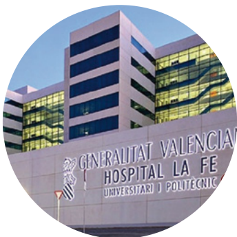
Hospital Nueva Fe de Valencia con nuestro sistema socket de P100
