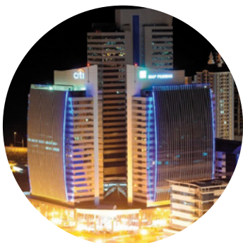
Reparación Edificio Las Americas de Panama
